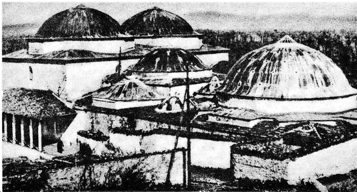
Exterior del Yeni Kapliya, baños situados cerca de Trusa, mostrando las cúpulas con las aberturas cubiertas de cristal en la parte superior.
